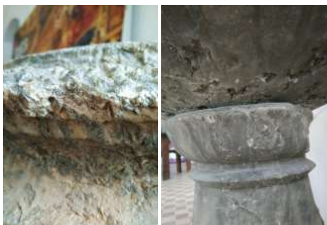
Рис. 8. Наслідки розчинення та вимивання гіпсу під впливом атмосферних опадів
